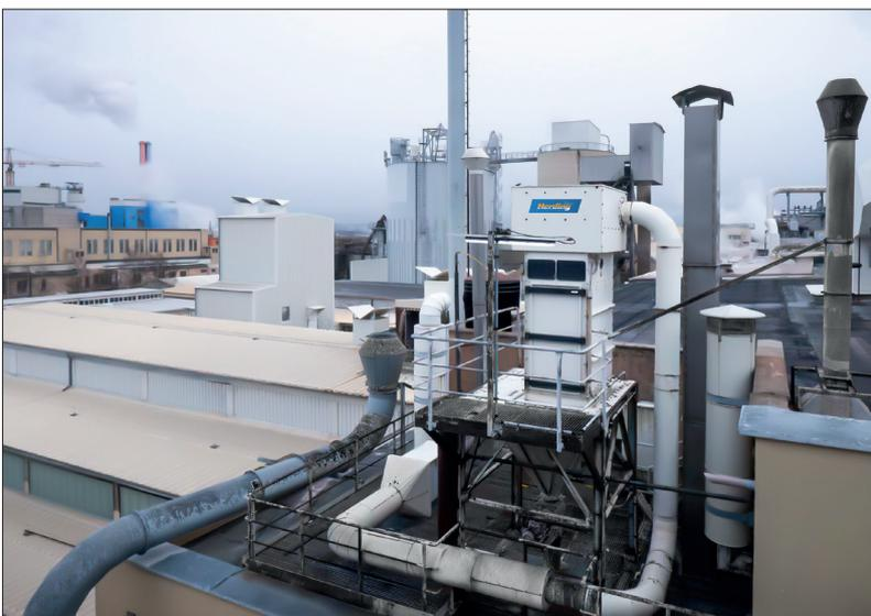
**Bild 3** Die hohe Effizienz der Staubabscheidung und die damit verbundenen geringen Staubemissionen, sowie die weitgehende Wartungsfreiheit sind die Gründe für den Einsatz von über 50 Herding-Filteranlagen bei Nabaltec
